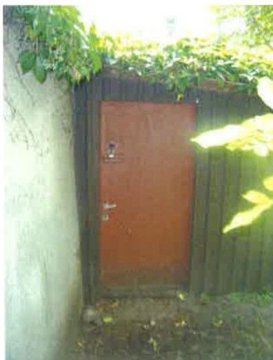
Dokumentacja fotograficzna — budynek gospodarczy przy ul. Miodowa 18
